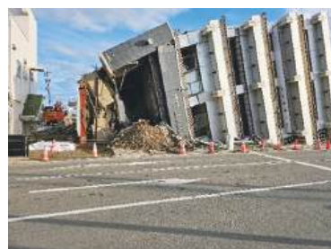
▲倒壊したビル(輪島塗 五島屋)
