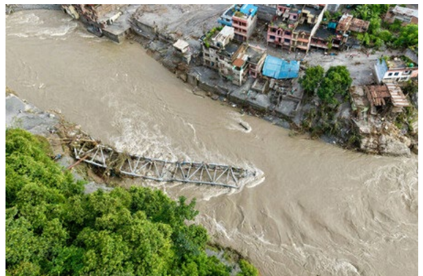
27日、ネパール東部バグマティ州で、土石流により崩落した橋（AFP時事）
