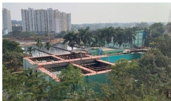
インド南部ベンガルールの都市と既設浄水場（NJSの発表資料より）
