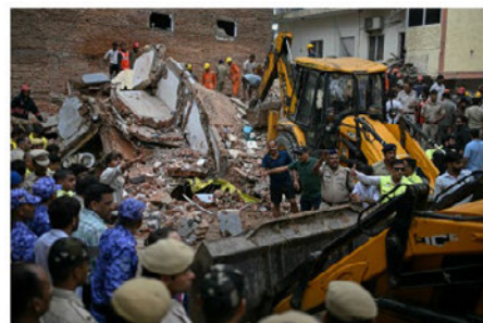
ビル崩壊現場で捜索が行われる中、残骸を撤去するブルドーザー=6日、ニューデリー(AFP時事)
